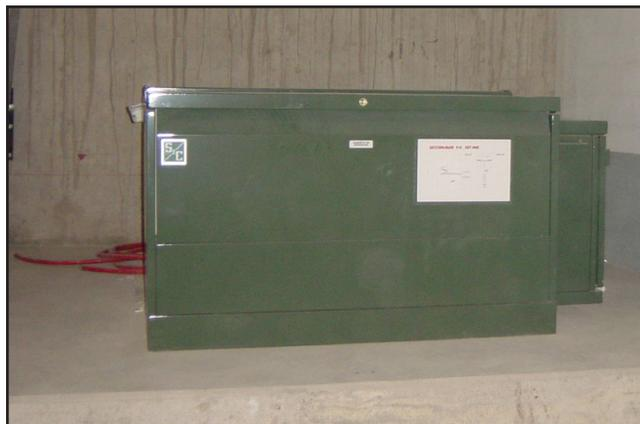
**Foto 1.** Unidad Vista localizada dentro de una sala de electricidad.
