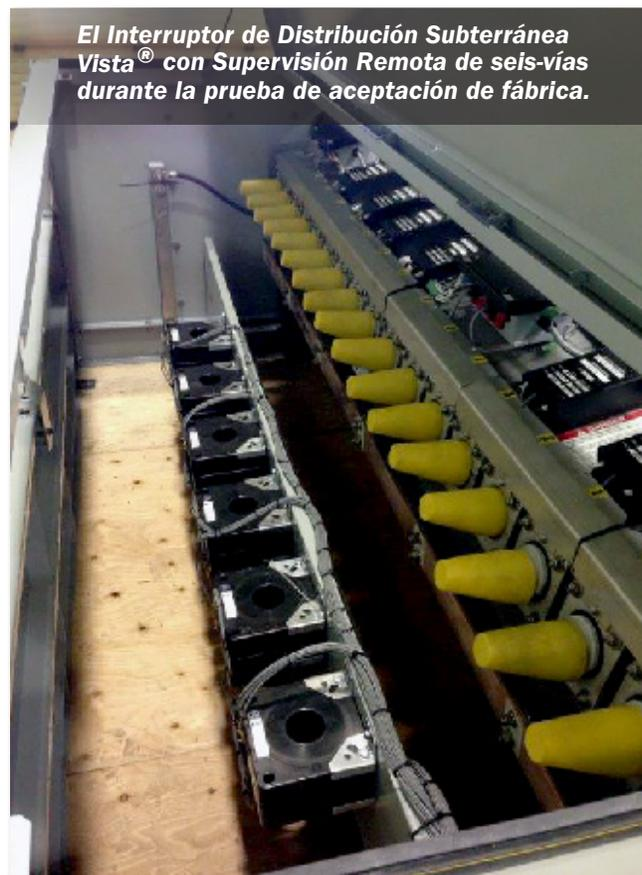
*El Interruptor de Distribución Subterránea Vista® con Supervisión Remota de seis-vías durante la prueba de aceptación de fábrica.*
