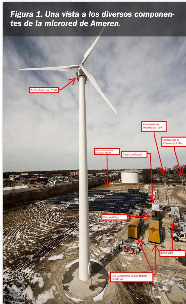
**Figura 1. Una vista a los diversos componentes de la microred de Ameren.**
